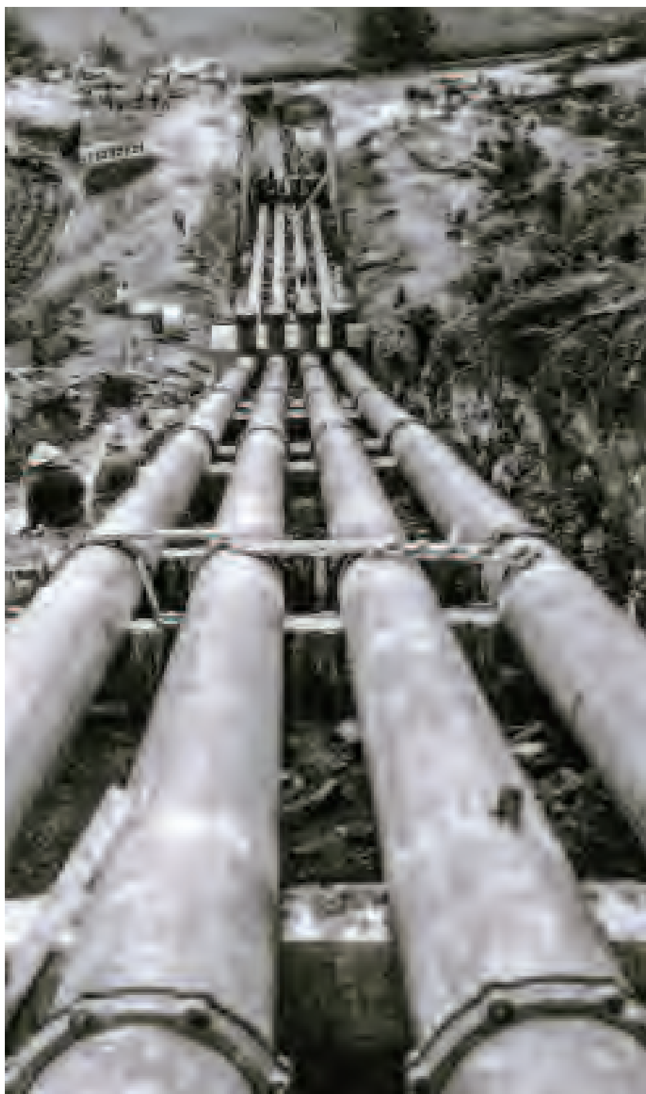
Obras para la captación de aguas del río Lerma, 10 de julio de 1951 (IZQUIERDA).
