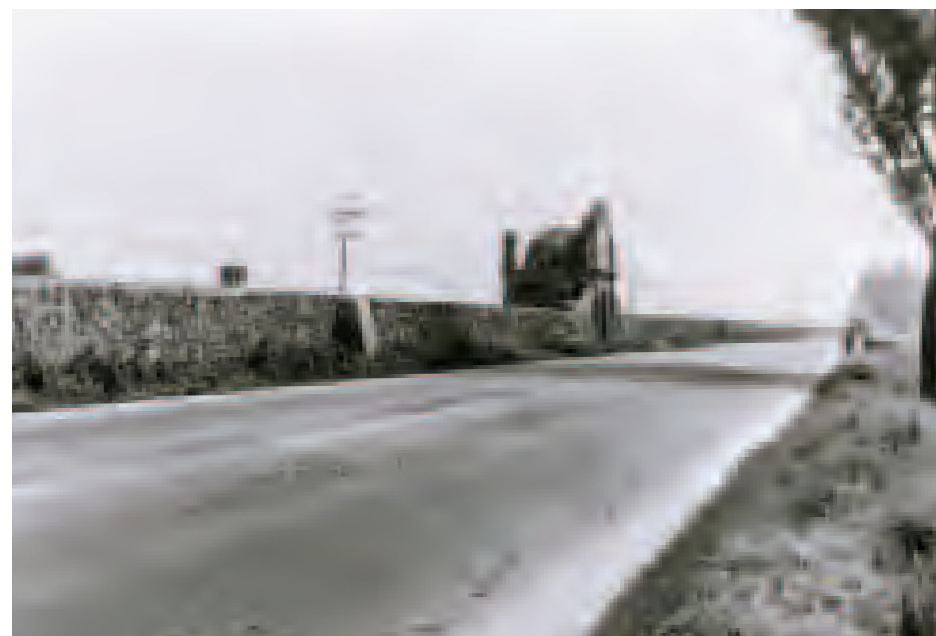
Restos del muro del albarradón de Ecatepec, separado por una de capilla. Camino Real México-Pachuca, Ecatepec de Morelos, Estado de México, (s/f).
