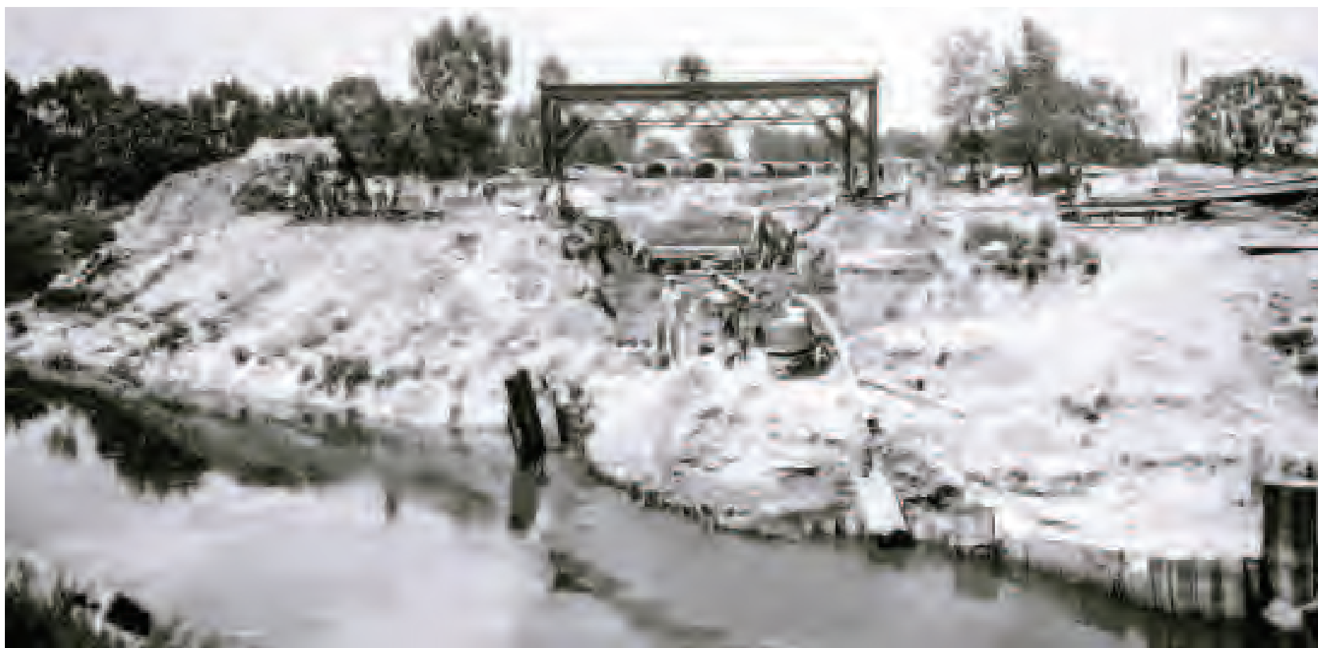
Hombres trabajan durante proceso constructivo del Gran Canal de Desague, Zumpango, Estado de México, circa 1905.
