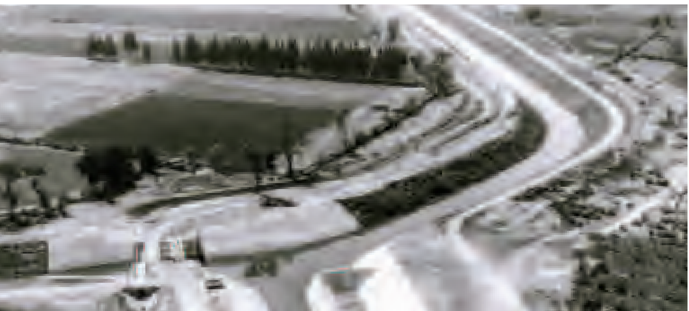
Estructura de derivación a Zumpango y Tajo de Nochistongo del canal Emisor Poniente, Santo Tomás, Estado de México, 1965 (ABAJO).
