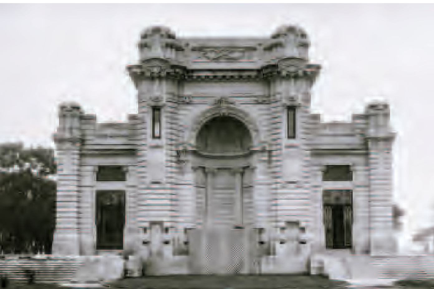
La casa de válvulas de La Condesa, 1928.
