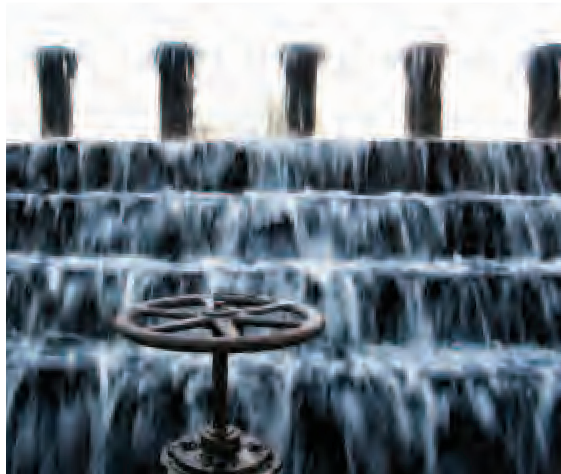
Planta potabilizadora El Tejar
